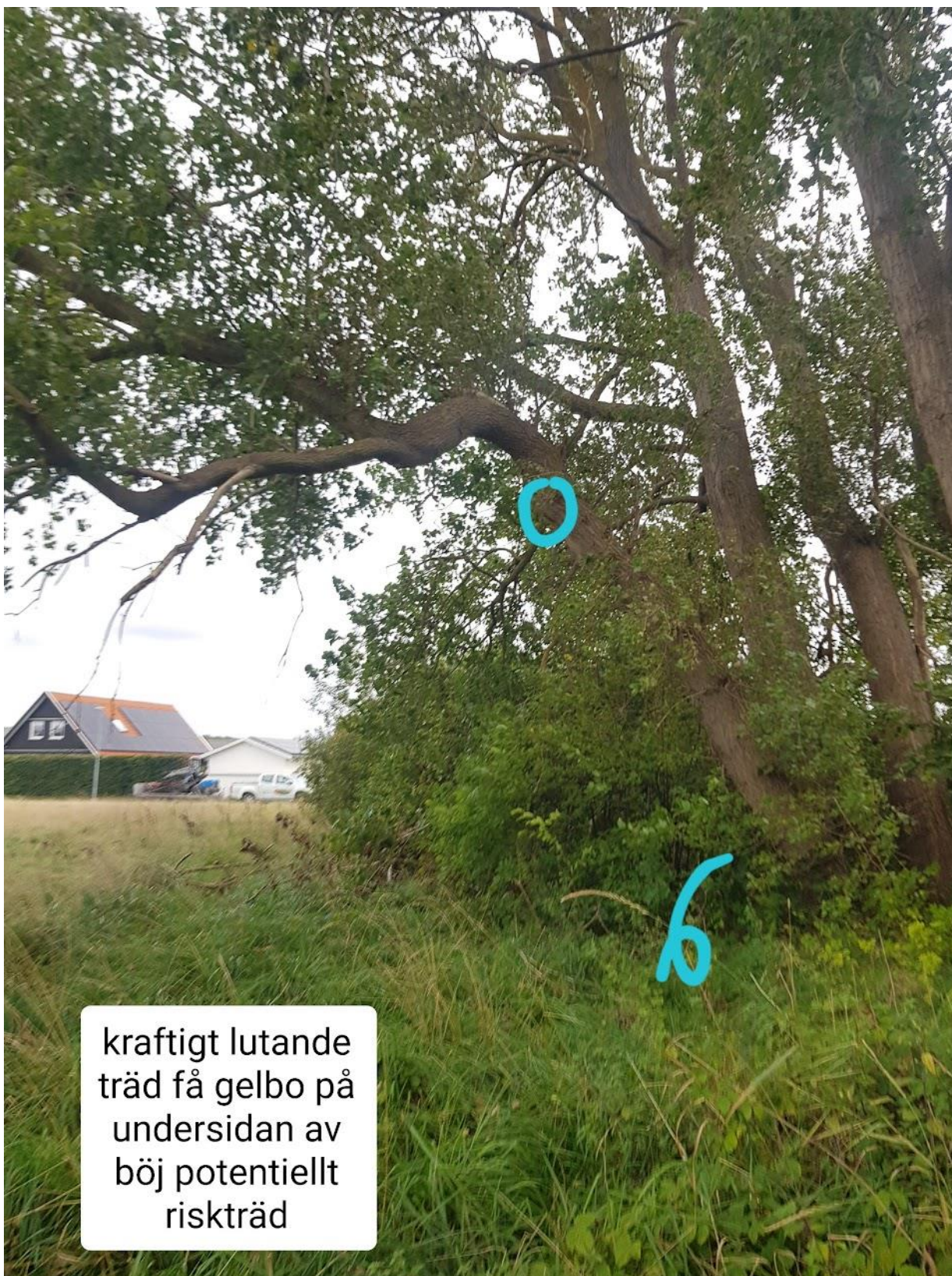
Kraftigt lutande träd. Fågelbo på undersidan av böj. Potentiellt riskträd.
