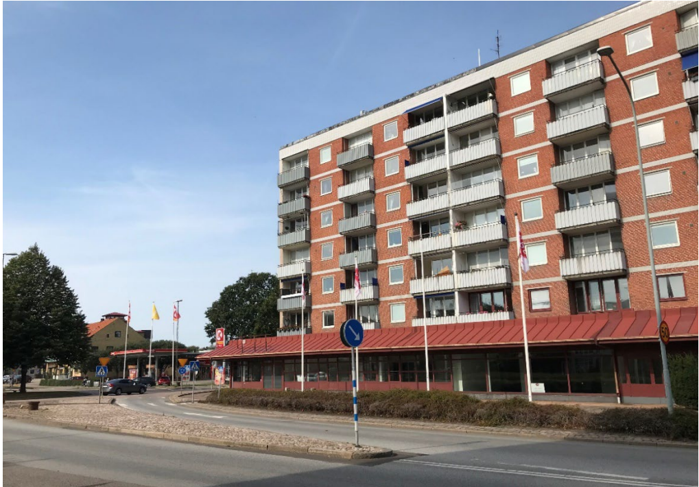
Foto: Byggnadskroppen mot Storgatan som avses behållas, vy mot rondellen/Triangelplatsen.
