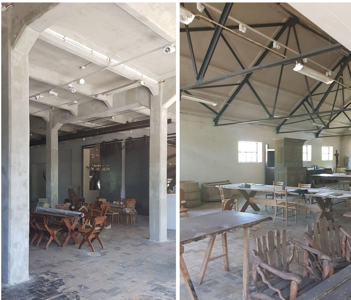
Den vänstra bilden visar konstruktionen med pelare och betongdäck. Den högra visar ståltakstolarna i den lägre delen.
