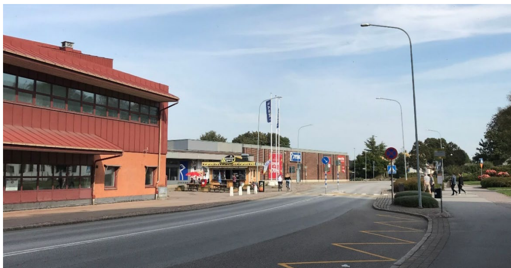
Foto: Den lägre delen av byggnaden som anses behållas, gamla Domus-byggnaden och grillen, vy österut längs Storgatan.
