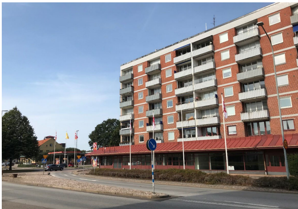
Foto: Byggnadskroppen mot Storgatan som anses behållas, vy mot rondellen/Triangelplatsen.
