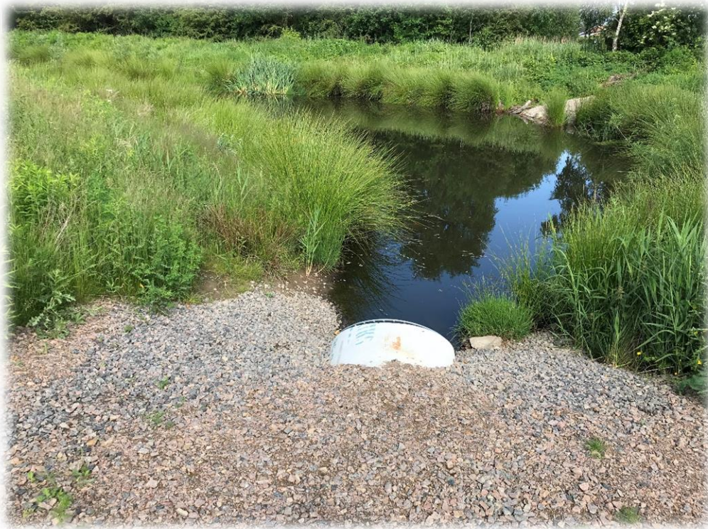
Figur 6. Öppet magasin med vattenspegel på Sjö Crona park Höganäs.
