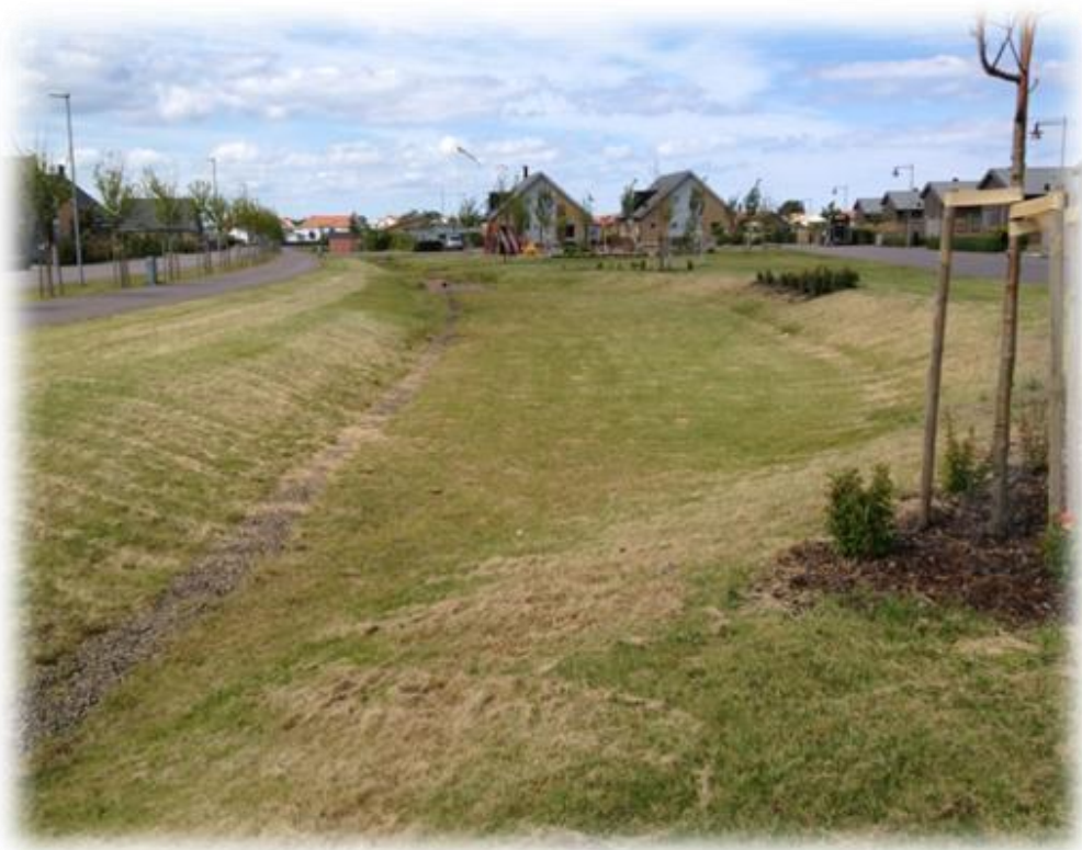
Figur 7. Öppet magasin utan vattenspiegel med genomströmning. Foto taget i Viken.
