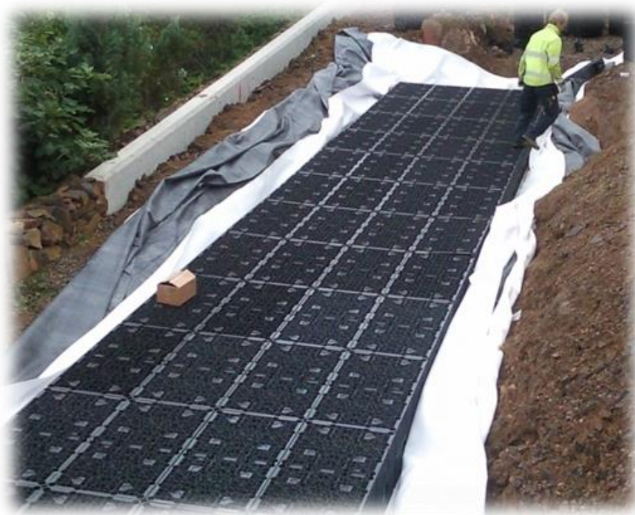
Figur 9. Underjordiskt magasin av plastbackar täckta med tätduk Foto taget i Mölle.
