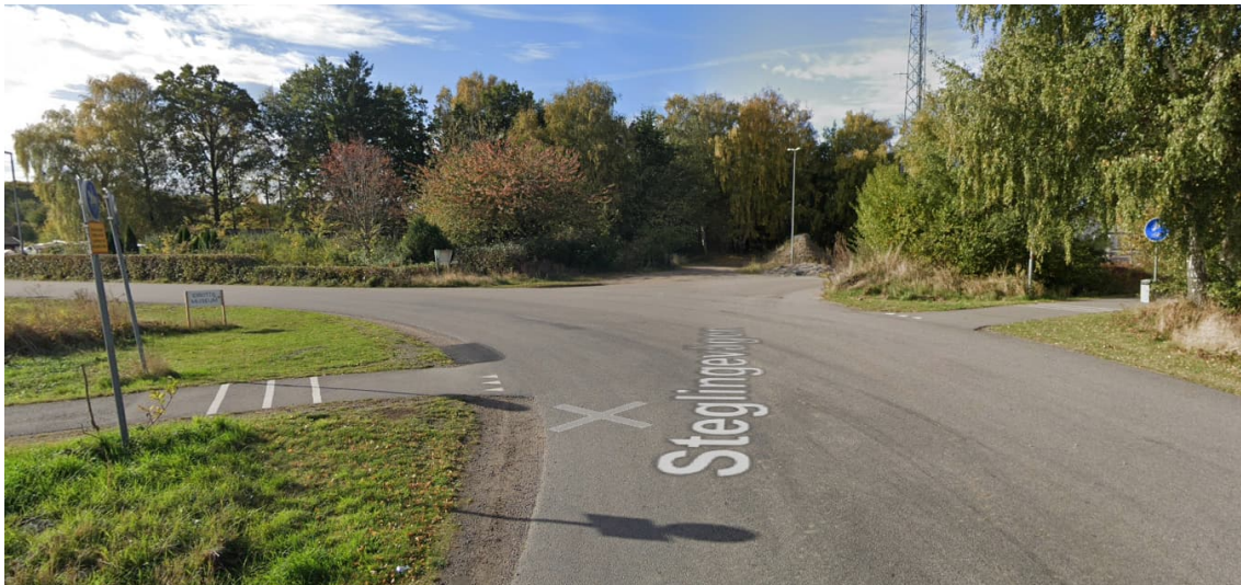
Figur 5 Gång- och cykelvägens anslutningar från väster och öster samt planområdets (södra delen) anslutning till Steglingevägen. Källa: Google Maps bildinsamling 2022.
